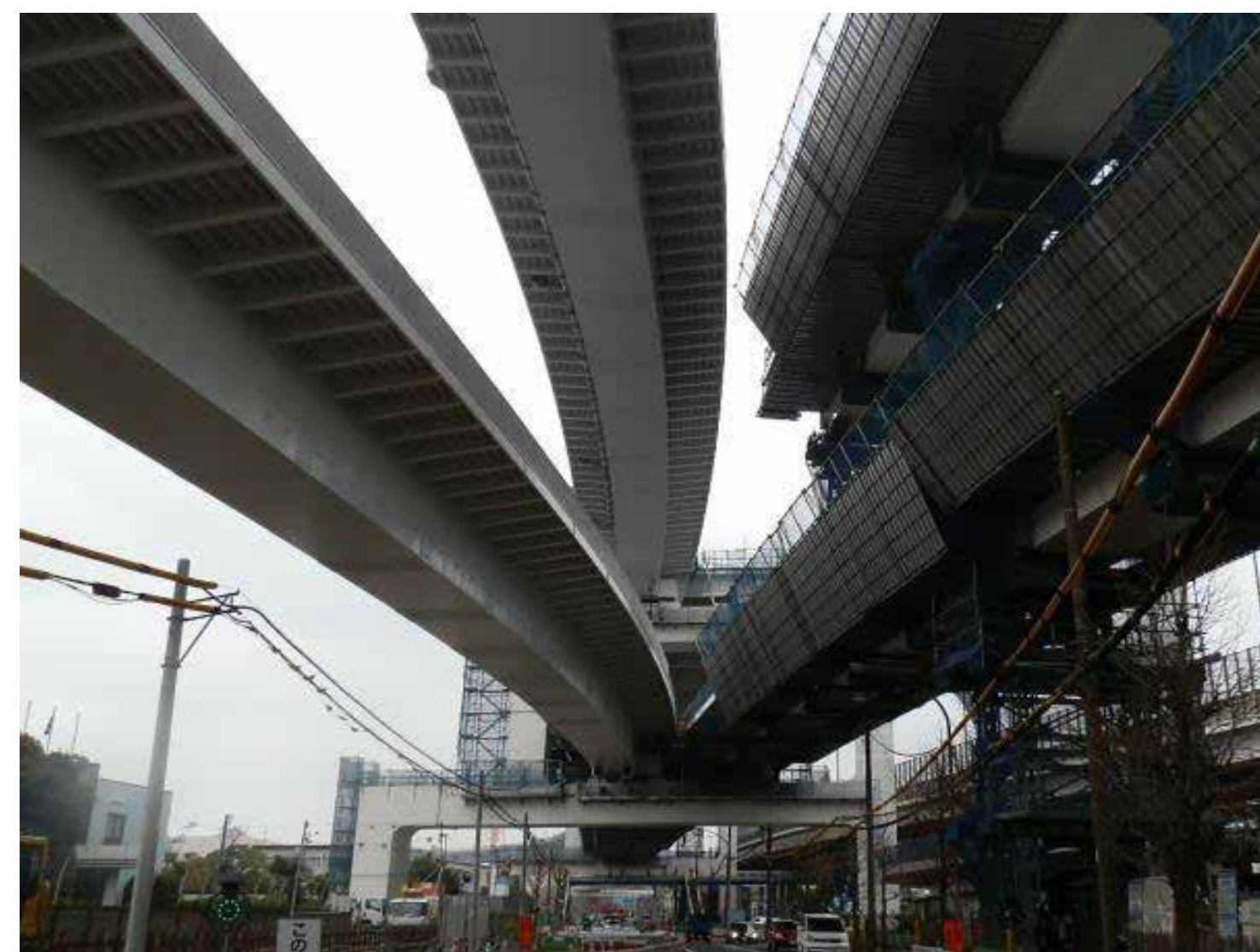
南本牧高架橋 2層構造の鋼床版箱桁橋
