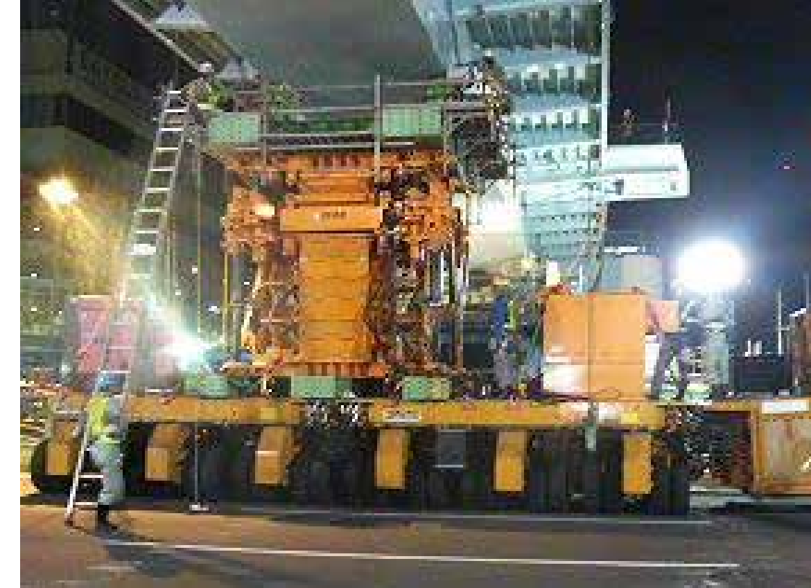
ステージジャッキ ステージジャッキ 200トンの橋を2メートル持ち上げます
