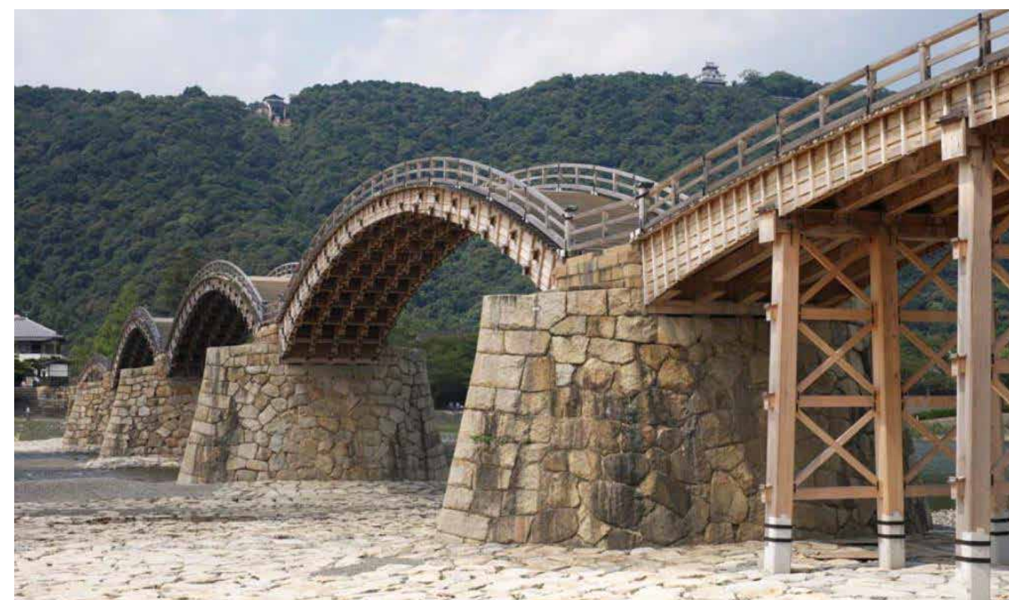
『木材』 錦帯橋 (山口県) 1673年建造
