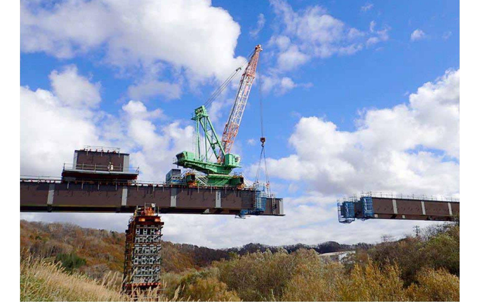
トラベラークレーン架設 橋の骨組みの上を移動できる特殊なクレーンを使って、橋げたを張り出しながらかける方法
