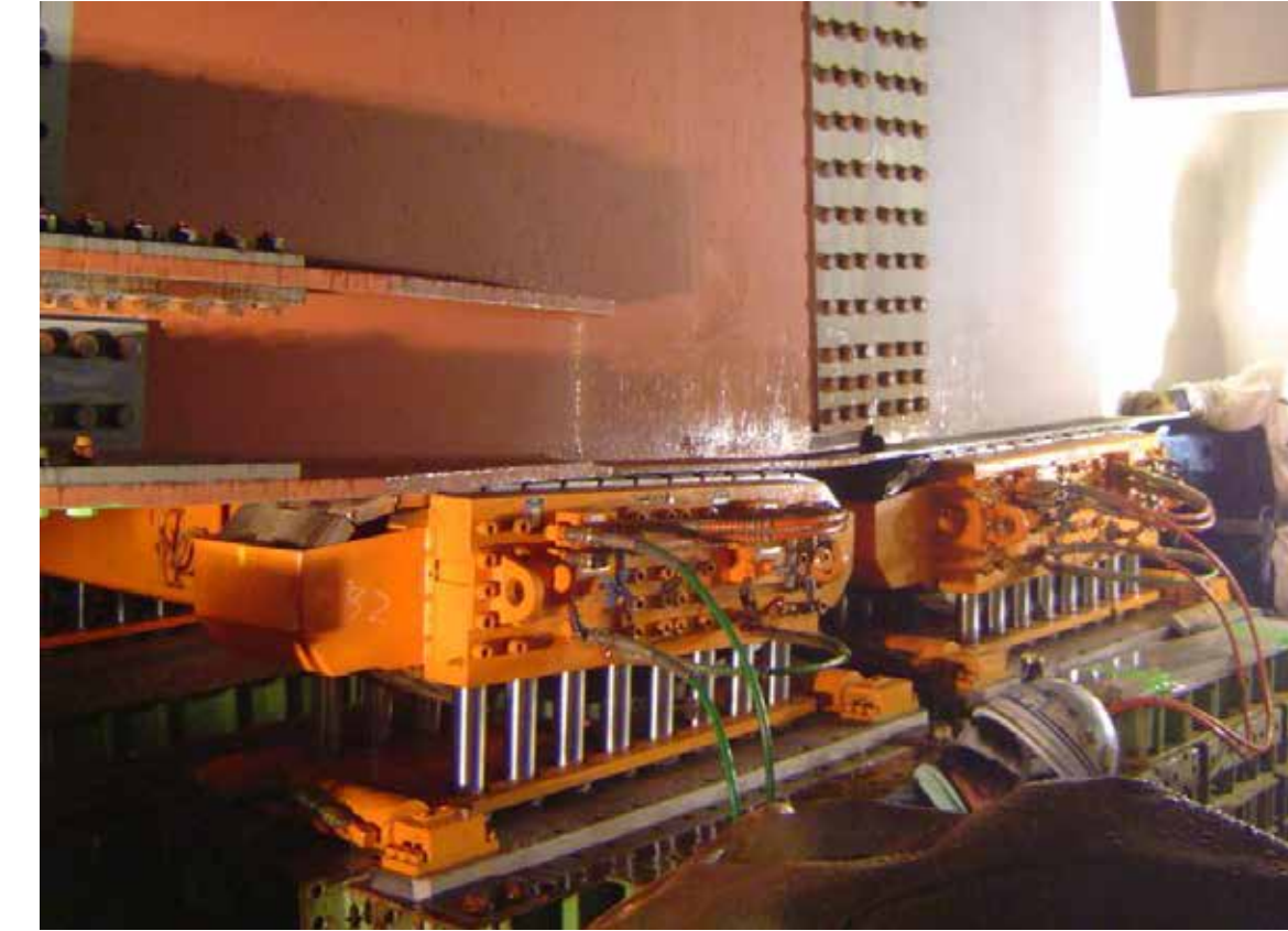
シンクロジャッキ シンクロジャッキ 上面が回転して橋げたを移動します
