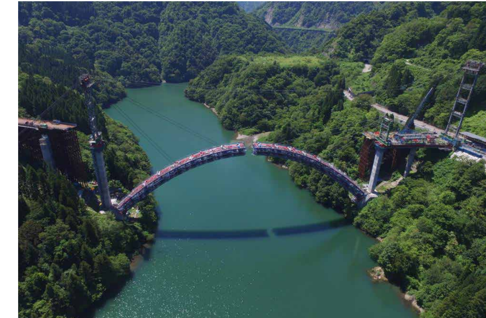
ケーブルエレクション架設 谷間など、クレーン車が使えない場所で、仮の鉄塔から張ったワイヤロープでアーチを支えながらかける方法
