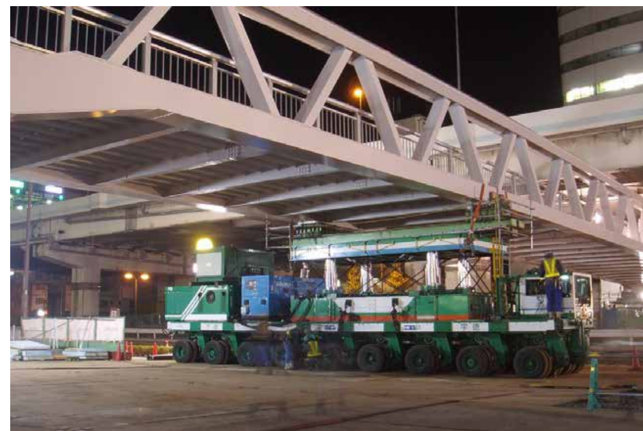
自走多軸台車 じそうたじくだいしゃ 72本のタイヤで300トンの橋を運びます
