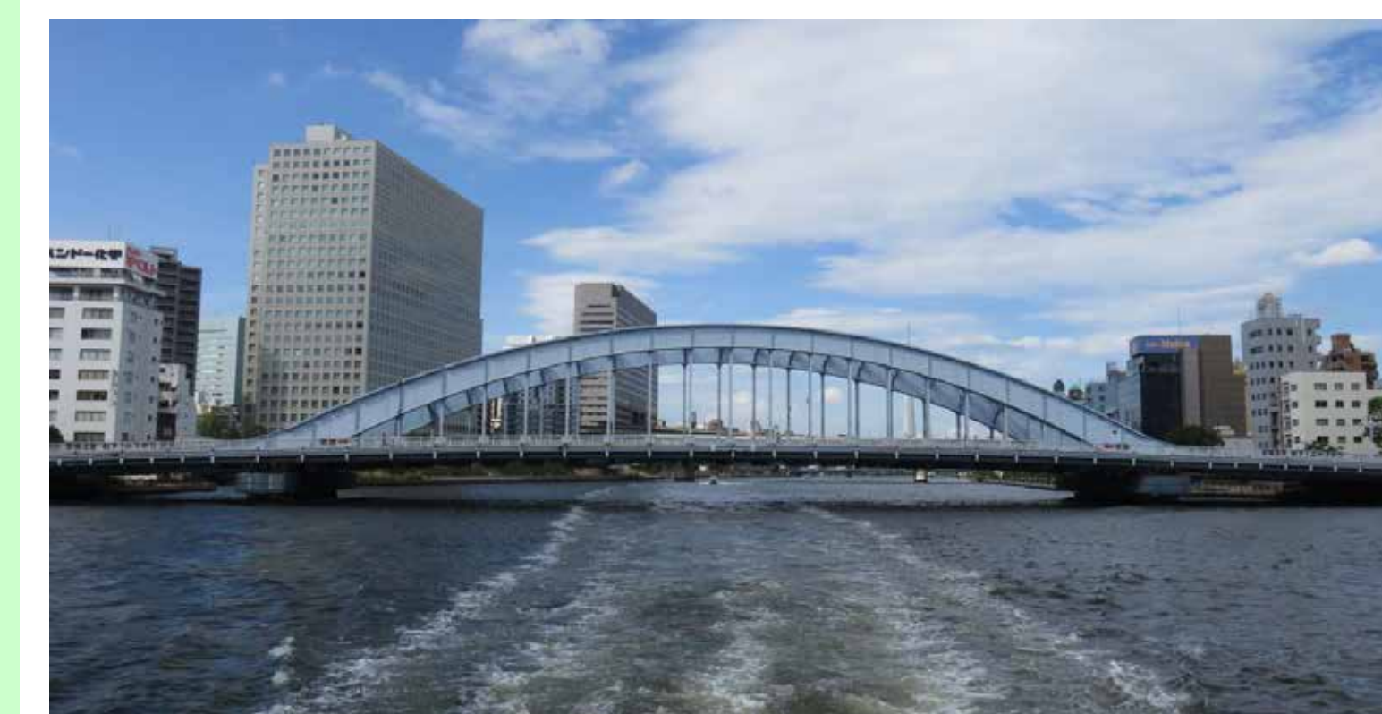
永代橋 大正15年(1926年) タイドアーチ橋 日本で最初に100mを超えた橋
