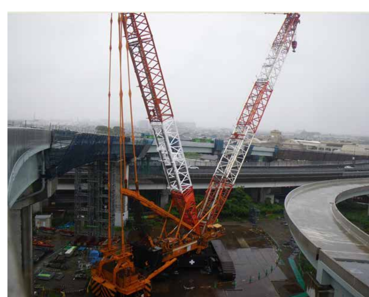
クローラクレーン クローラクレーン 国内最大級1250トン吊り!
