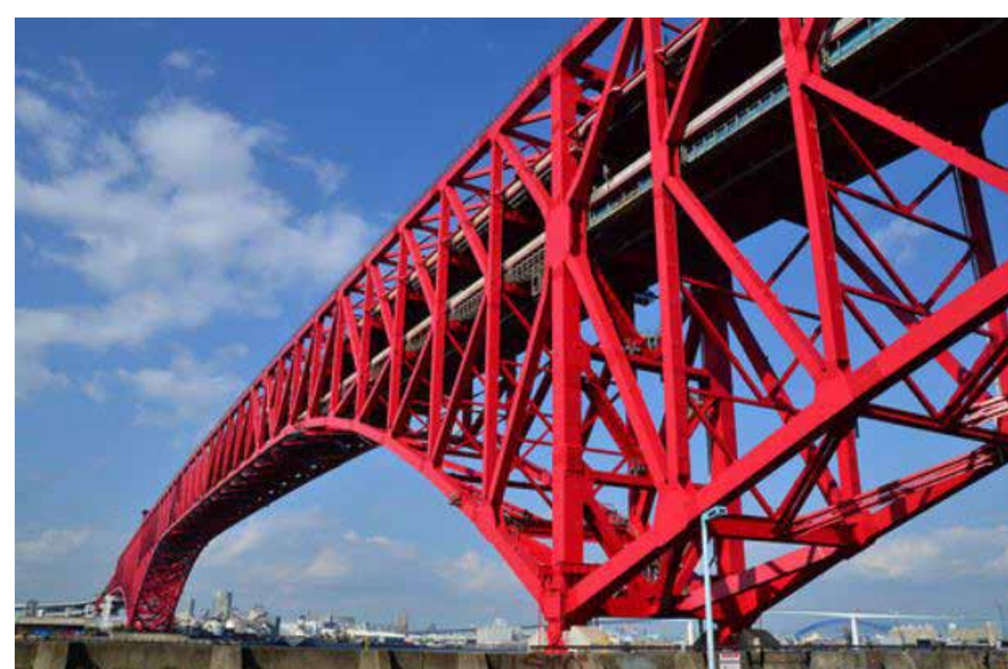
『鉄』 港大橋 (大阪府) 1974年建造
