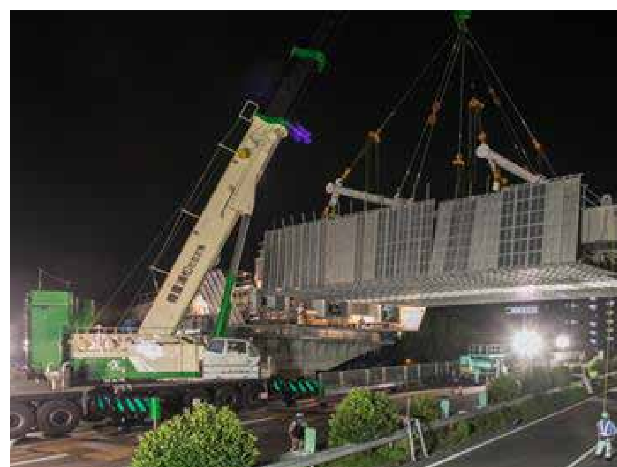
トラッククレーン トラッククレーン 100トンもの橋げたを吊り上げます
